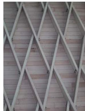
In den Knotenpunkten wurden jeweils drei Lamellen, von denen die mittlere durchlaufend ausgeführt wurde, durch Bolzen verbunden. Der Anschluss der Lamellen an die Auflager ist ähnlich einfach wie die Knotenverbindung mit einer Bolzenverbindung ausgeführt. Mit der aufgenagelten Dachschalung entsteht aus den Rauten-Stabwerk ein Schalentragerwerk.
