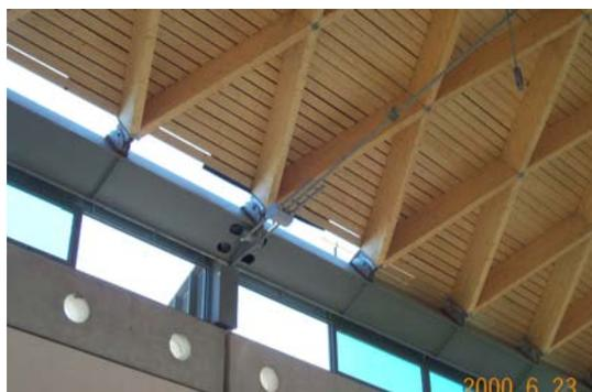
Bild 12 Randträger mit Auflagerschuh und Zugband
