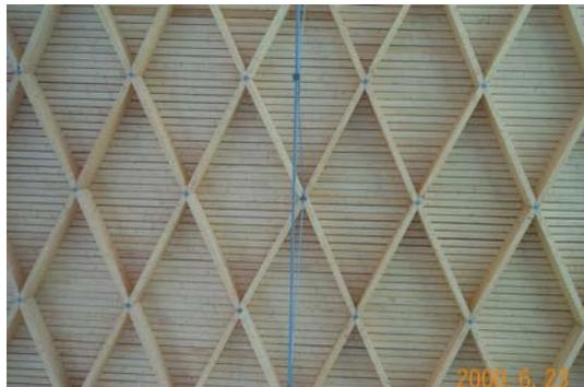
**Bild 14** Deckenuntersicht mit Zugband
