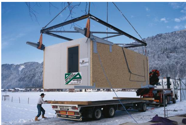
Abbildung 8: Montage der Module
