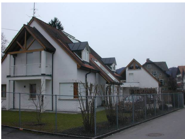
Abbildung 27: vor dem Umbau
