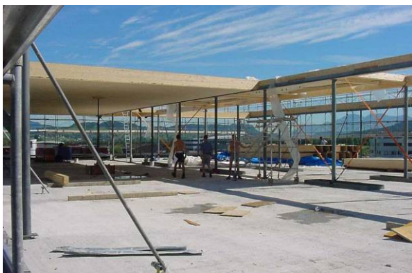
Abbildung 20: Bau der Aufstockung Ivoclar, Schaan
