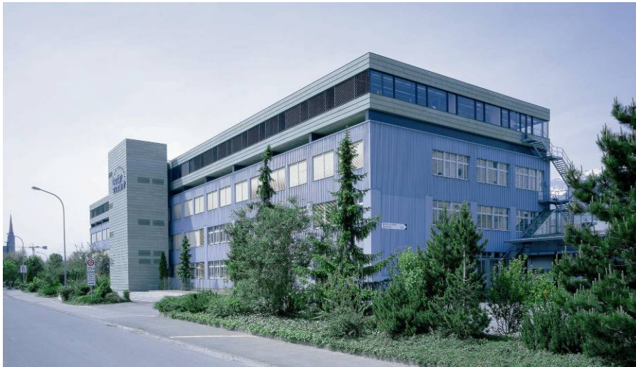
Abbildung 19: Aufstockung Ivoclar, Schaan (Liechtenstein) Architektur: DI Christian Lenz, Schwarzach
