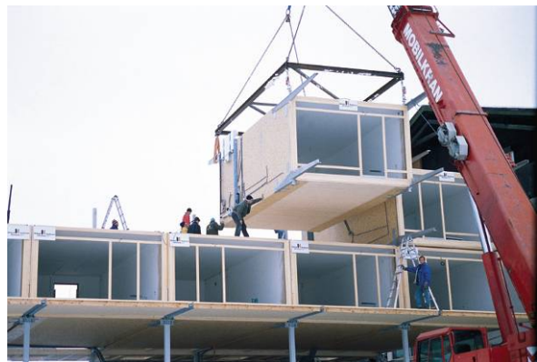
Abbildung 9: Montage der Module
