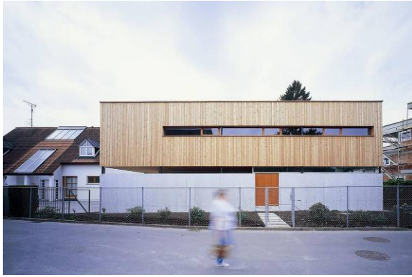
Abbildung 29: nach dem Umbau
