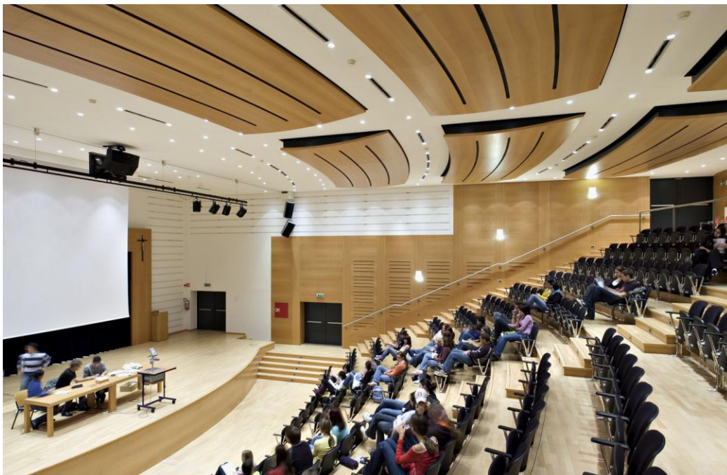
Abbildung 5: Decken- Wandabsorber in Holz und Gipskarton mit eingebauten Resonatoren Aula Magna „Gasteiner“, Bozen 2001
