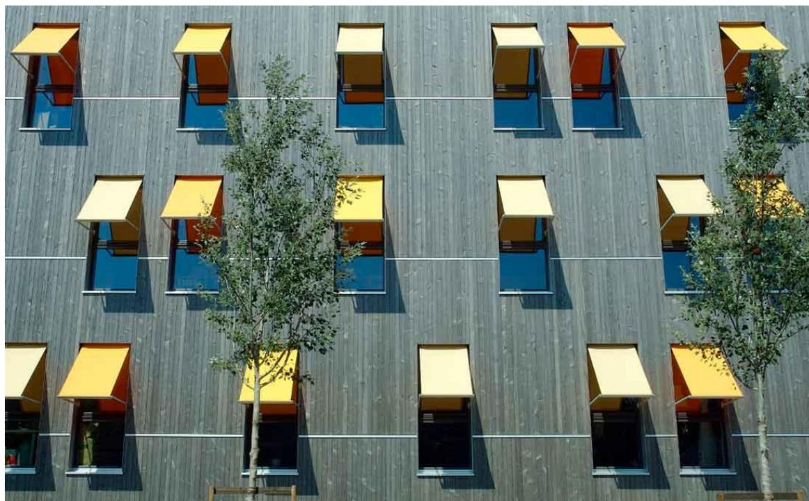
Abbildung 9: Holzfassade von BLOOD-Bekleidung, die regelmäßige vorgefertigte silberne Patina dank enzymatischen Prozessen ([www.schillinger.ch](http://www.schillinger.ch))
