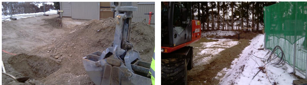
Abbildung 21-22: Aushub – Vorbereitung der Baugrube
