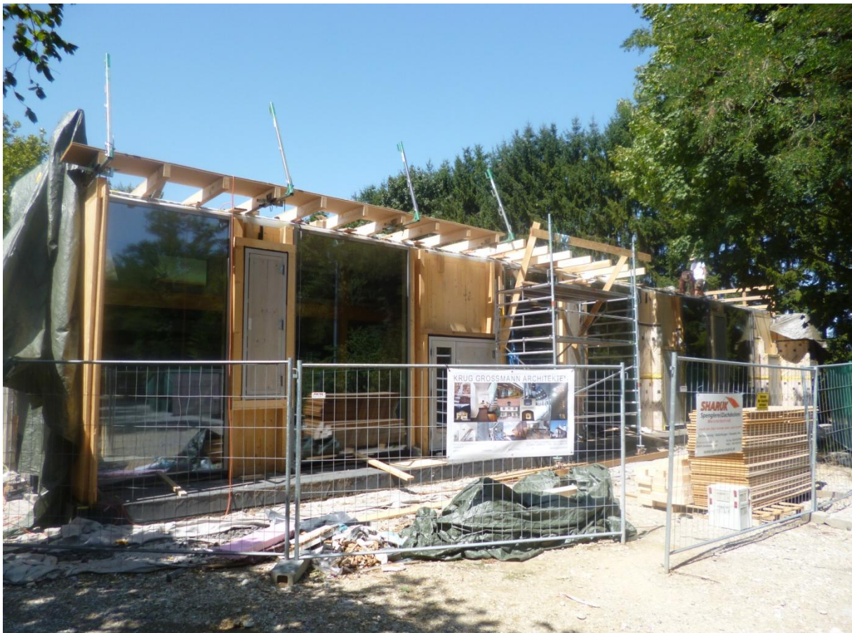
Abbildung 34 : Bau des Vordachs
