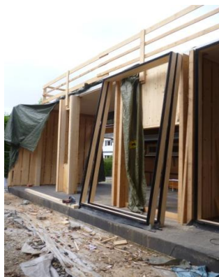
Abbildung 29-31 : Ligno-Trend Deckenelemente mit Sichtoberfläche und Beginn Montage Fenster
