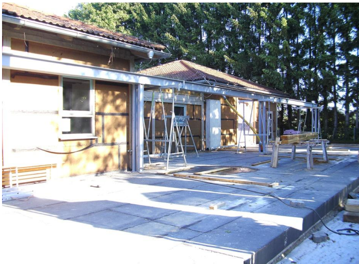
Abbildung 27: Neubau – Rinnenträger wird aufgestellt
