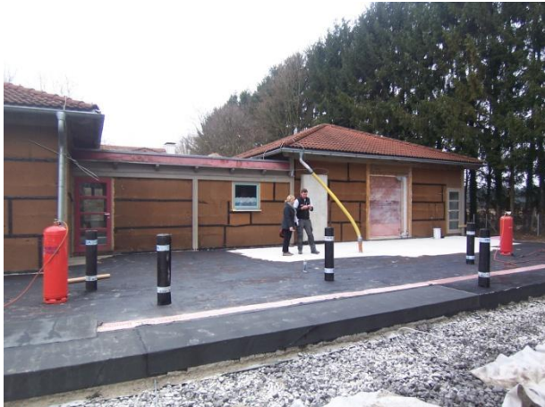
Abbildung 25: Neubau – Beginn der Zimmererarbeiten
