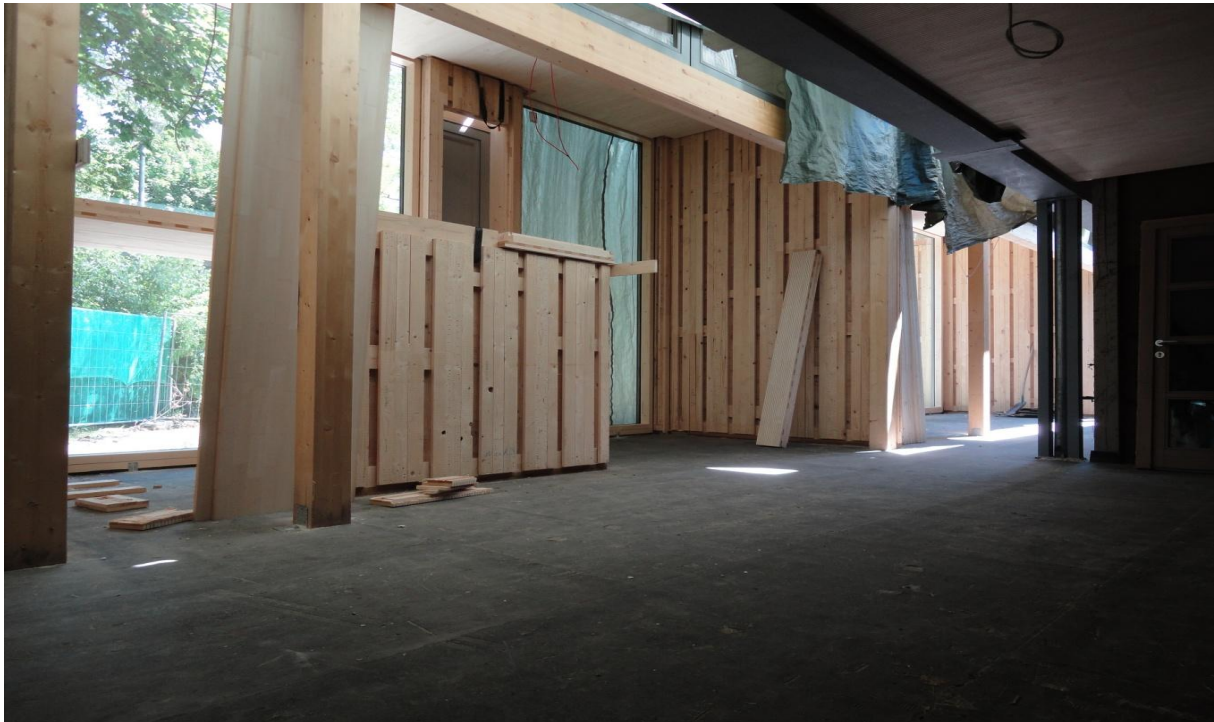
Abbildung 33 : Ligno-Trend Deckenelemente mit Sichtoberfläche und Beginn Montage Fenster
