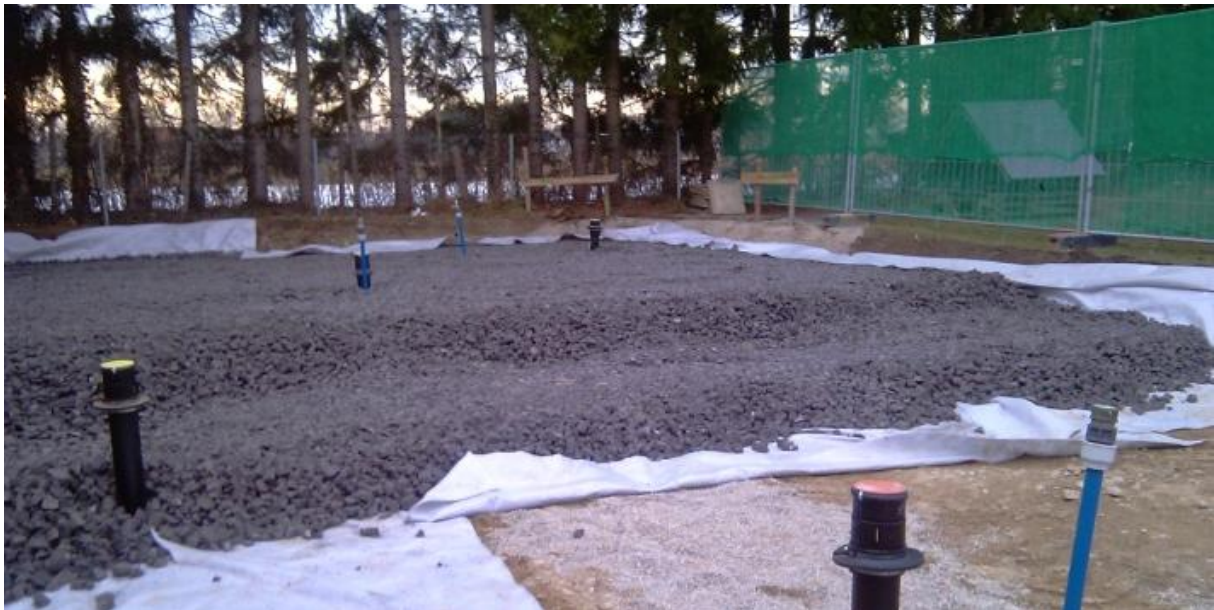
Abbildung 23: Flachgründung mit Glasschaumschotter
