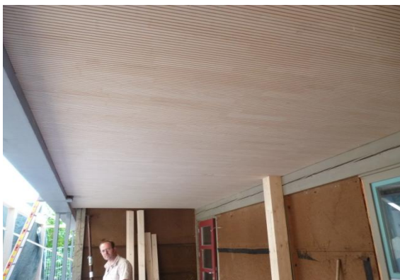
Abbildung 29-31 : Ligno-Trend Deckenelemente mit Sichtoberfläche und Beginn Montage Fenster
