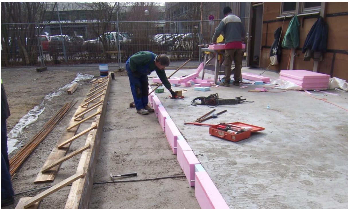
Abbildung 24: Thermische Trennung, Betonage
