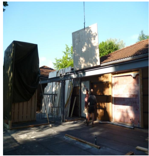
Abbildung 28: Montage der Ligno-Trend Wände
