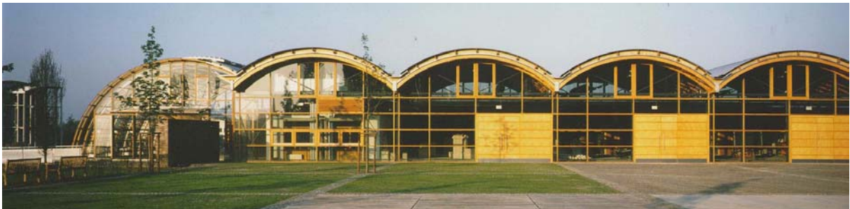
Bild 3 Schulungsgebäude Oeko-Zentrum Hamm
