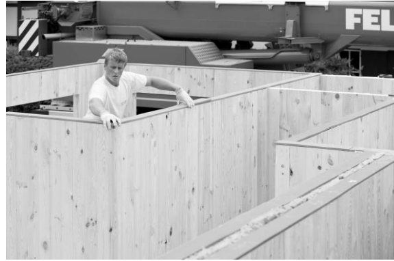
Abbildung 7: Verlegen der Sylodyn® Lager
