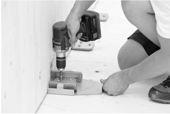
Abbildung 12: Verschrauben des Winkels
