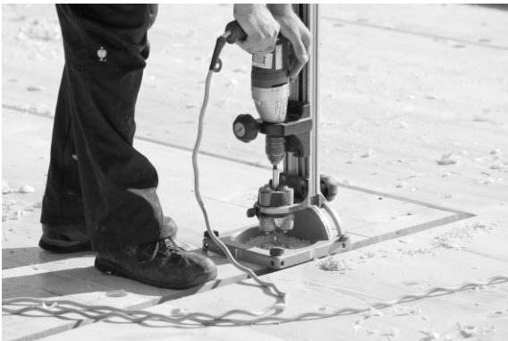
Abbildung 8: Vorbohren der Schraubenlöcher
