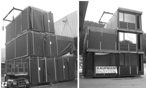
Abbildung 17: Aufeinander gestapelte Module
