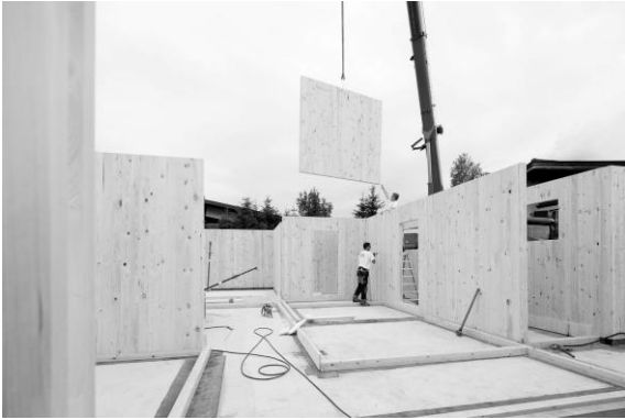
Abbildung 6: Aufstellen der Erdgeschosswände
