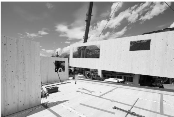
Abbildung 10: Verlegte Sylodyn® Lager
