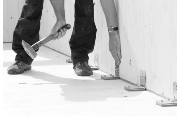
Abbildung 13: Vernageln des Winkels
