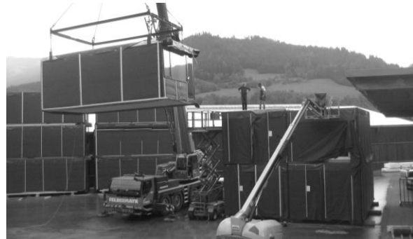
Abbildung 18: Stapeln der Module (Quelle: Künz)
