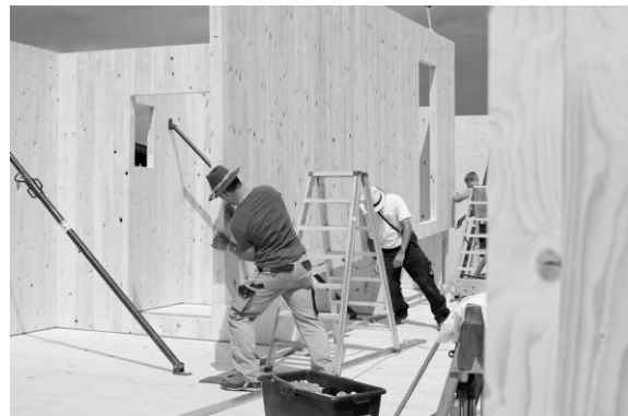
Abbildung 11: Aufstellen der OG Wandelemente
