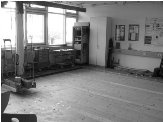
Abbildung 1: Messlabor mit BSH-Decke
