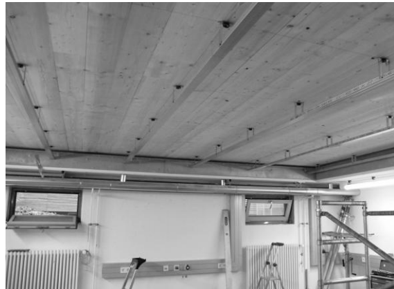
Abbildung 2: Vorbereitung der Unterdeckenkonstruktion
