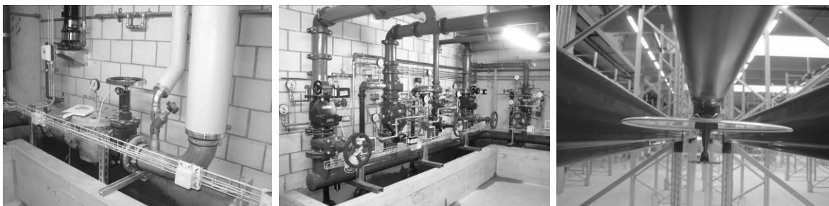
Abbildung 7: Wasserzuleitung /Sprinklerzentrale/ Sprinklerrohrnetz/Quelle Siemens
