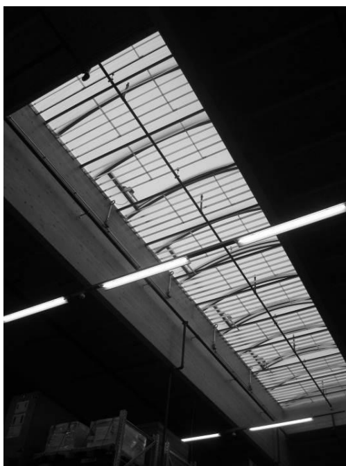
Abbildung 4 und 5: RWA-Kuppeln in Hallen und Treppenhäuser / Quelle Siemens
