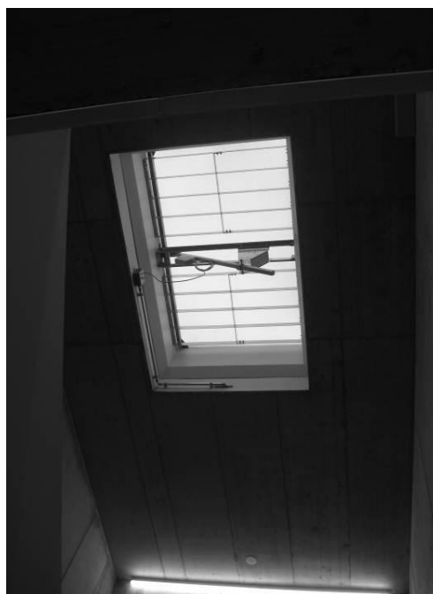
Abbildung 4 und 5: RWA-Kuppeln in Hallen und Treppenhäuser / Quelle Siemens
