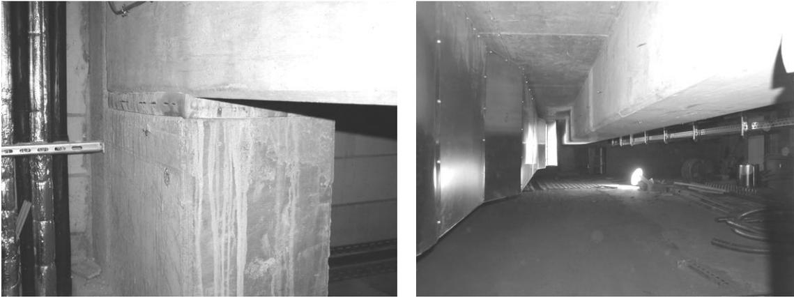
Abbildung 2: Elastische Lagerung der Bodenplatte des ARRI Film & TV Mischkinos Stage 1
