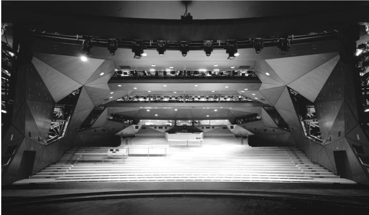
Abbildung 2: Schwerentflammbare, echtholz furnierte Akustik-Wand-/Deckenverkleidung (B1) am Schauspielhaus Stuttgart:
