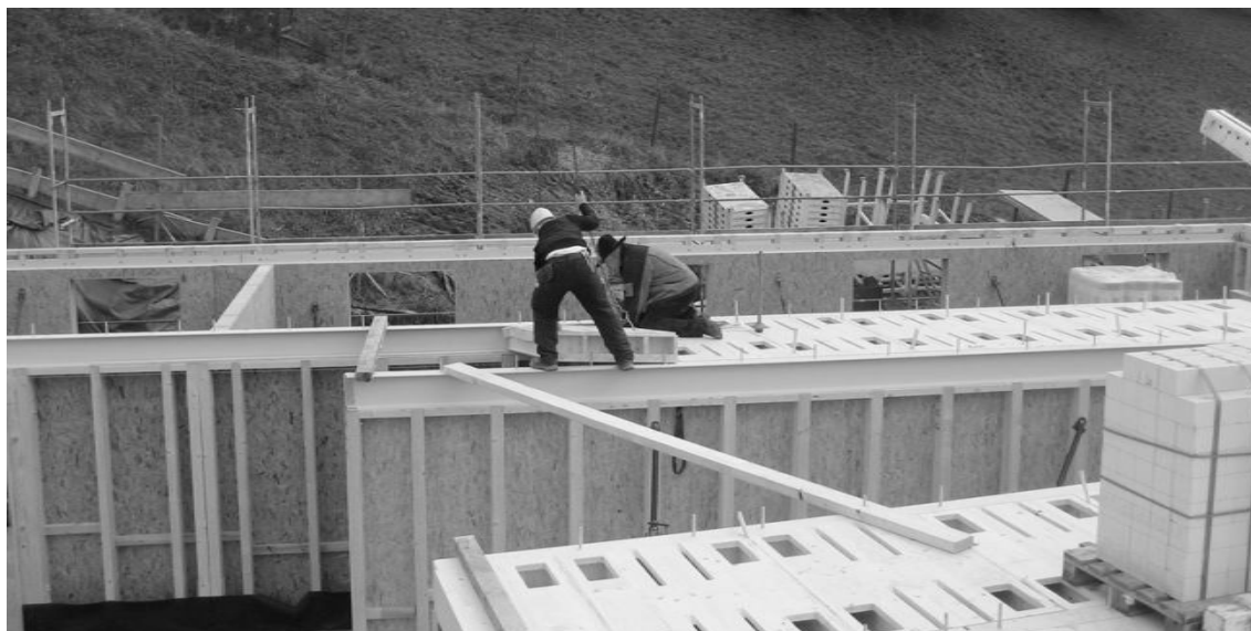
Abbildung 5: Hohlkasten-Deckenelemente Studentenwohnheim Neuhalde
