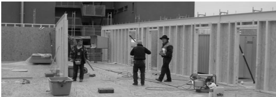
Abbildung 3: Wandkonstruktion Studentenwohnheim in Holzrahmenbauweise
