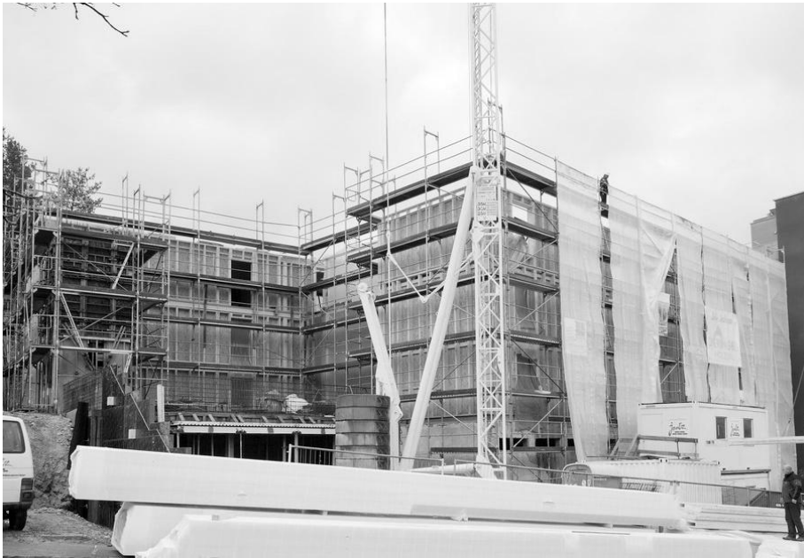
Abbildung 2: Bauzustand Holzbau mit eingerüstetem massiven Treppenhaus links hinten
