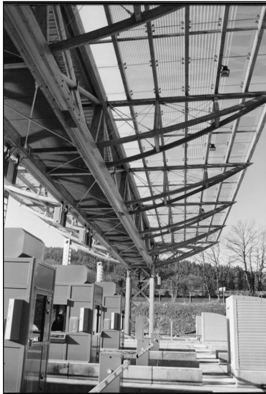
Abbildung 5 - Kastenträger mit seitlichen Auskragungen
