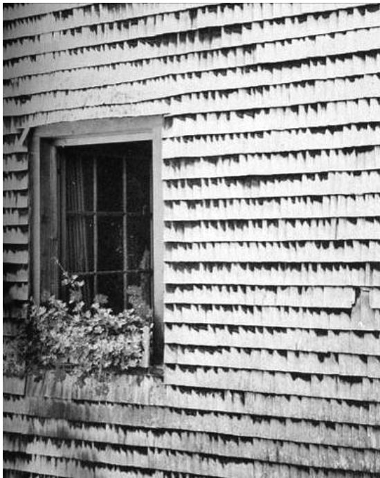
Abbildung 31: Schindelfassade
