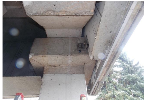
Detail – Eckstütze mit vorgehängter Stahlbetonfertigteiltfassade
