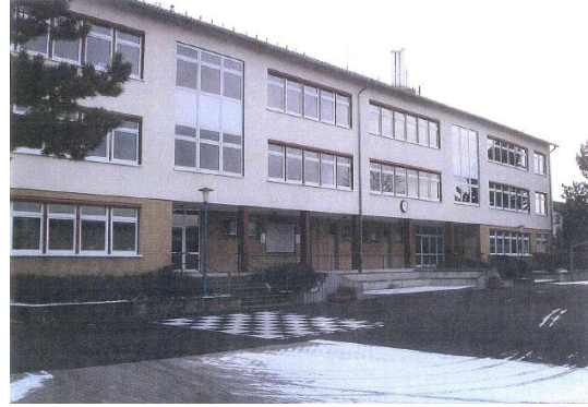
Schule vor der Sanierung
