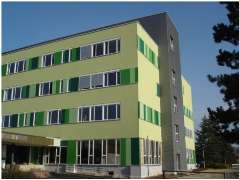
Schulbau nach der Sanierung Planung: Architekturbüro Kirschner+ Partner, Heringen
