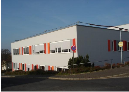
Schulbau nach der Sanierung Planung: Architekturbüro Kirschner+ Partner, Heringen
