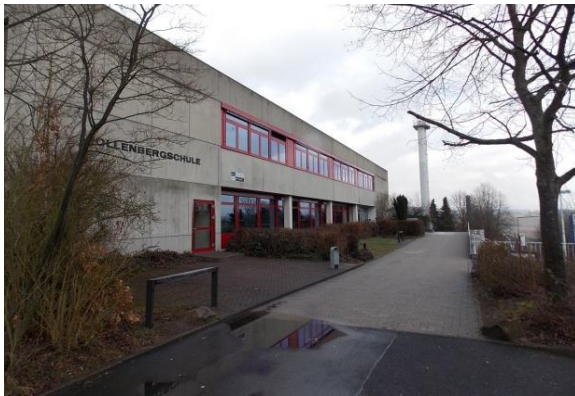
Schule vor der Sanierung
