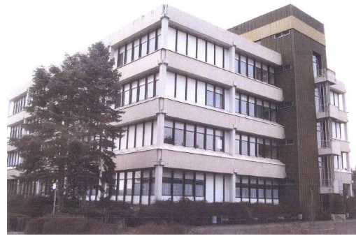
Schule vor der Sanierung
