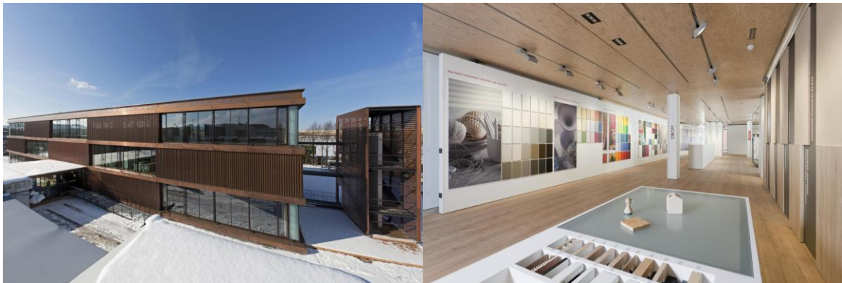
Abbildung 5: Ansicht Forum vom Bestand aus, Innenansicht Ausstellung Erdgeschoss (Deutschland)
