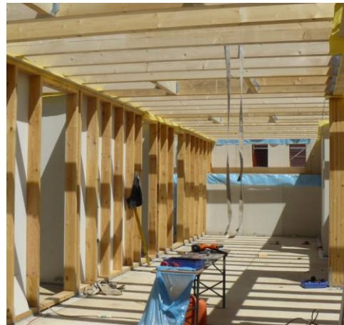
Abbildung 6: Holztragwerk 2
