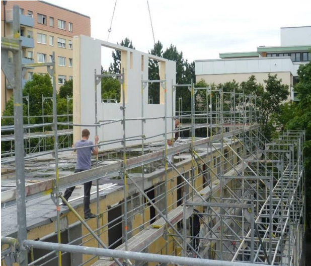
Abbildung 3: Einfädeln der Fassadendämmung – Modernisierung mit Holzkonstruktion.
