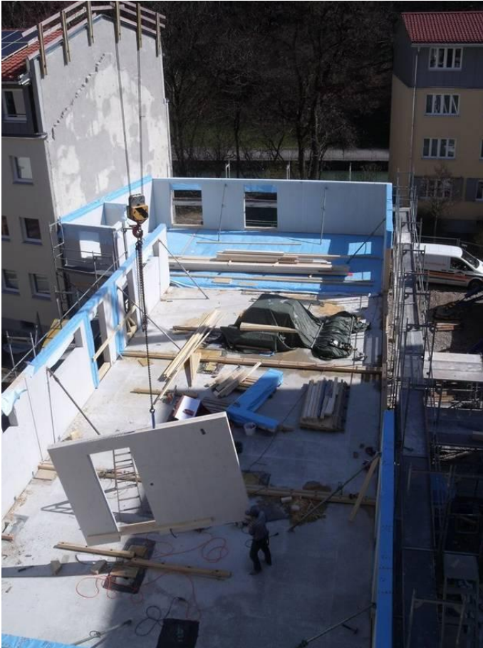
Abbildung 1: Bild von der Baustelle Baulückenschließung
