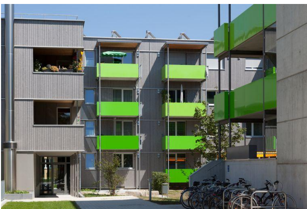
Abbildung 4: Ansicht der fertigen Maßnahme
