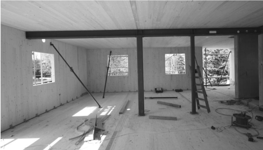
Abbildung 3: Innenraum während der Bauphase
