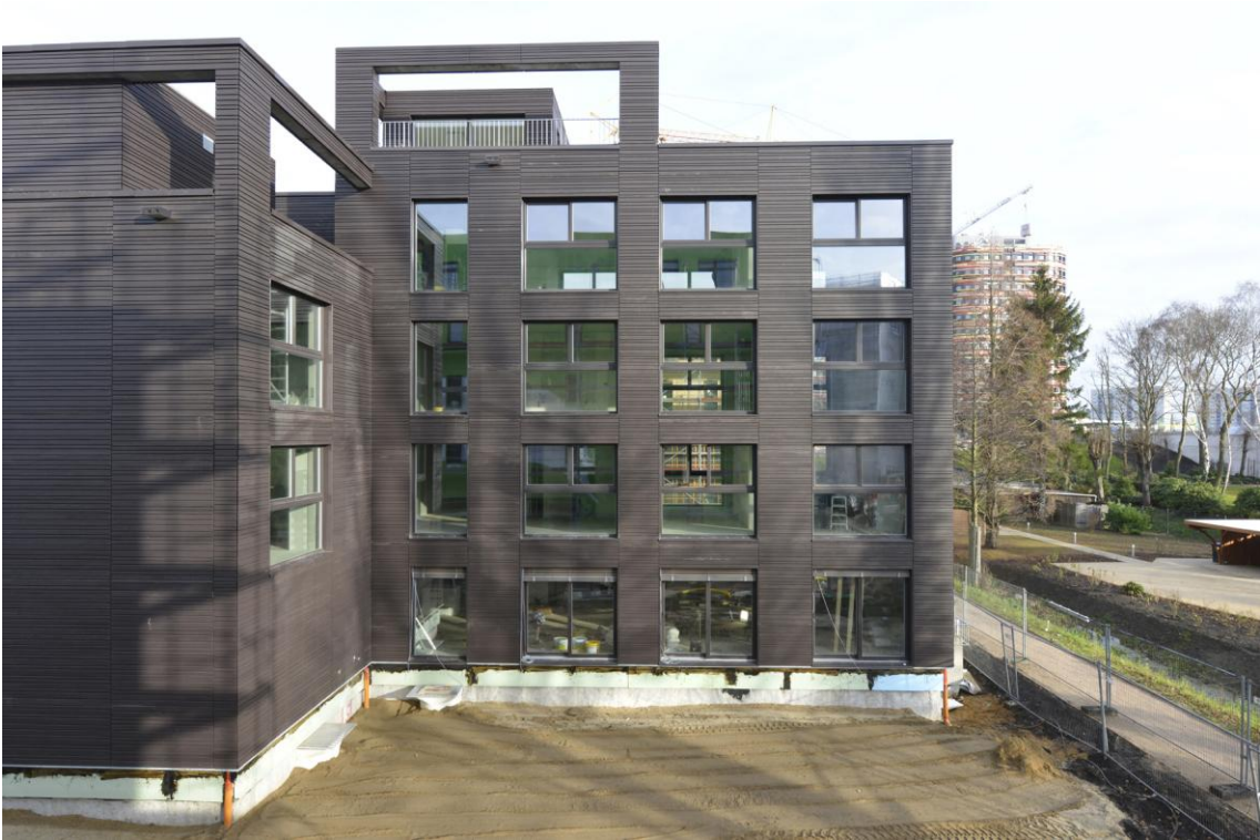
Abbildung 3: Gartenansicht von Süden
