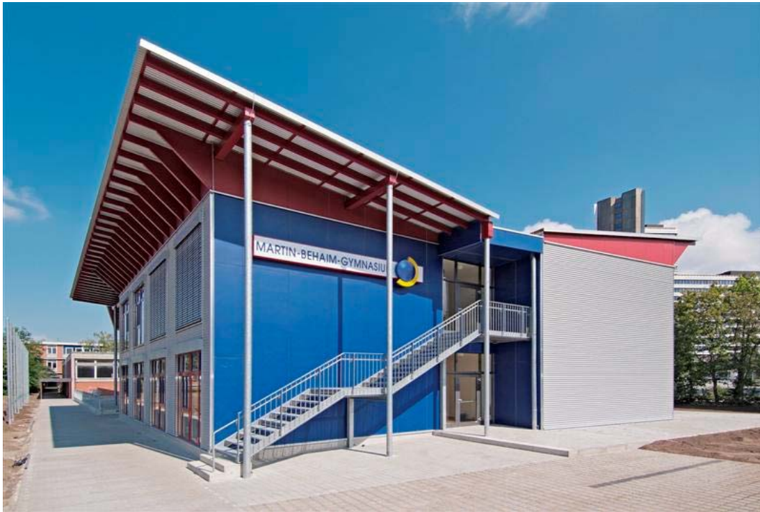
Abbildung 13: Seitenansicht Martin Behaim Gymnasium, Nürnberg
