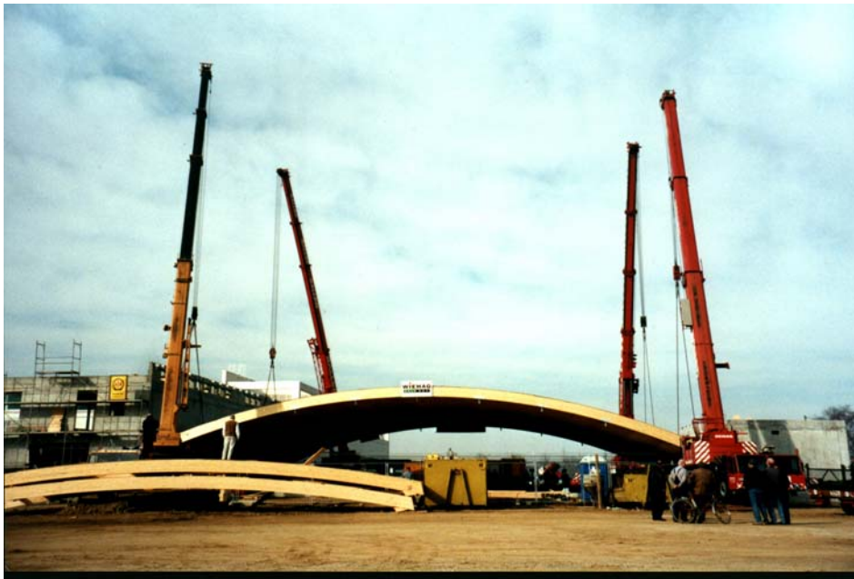
Bild 3: Einheben der Schale
