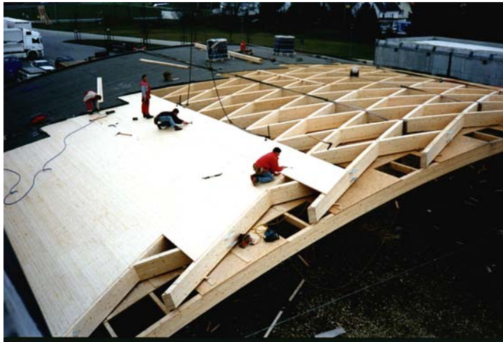
Bild 2: Montage der keilaezinkten 3-S-Platten
