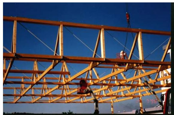
Bild 5: Montage der Tragwerksteile
