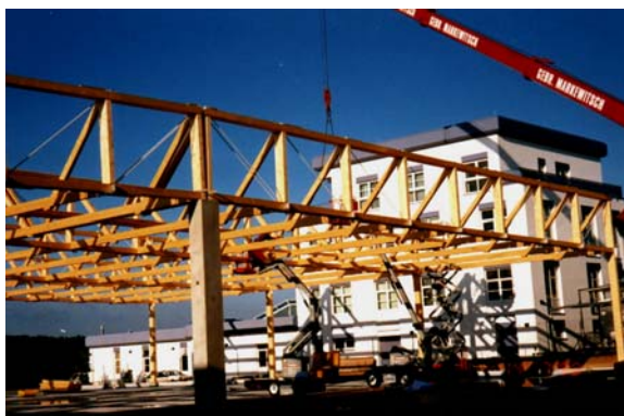
Bild 4: Montage der Tragwerksteile
