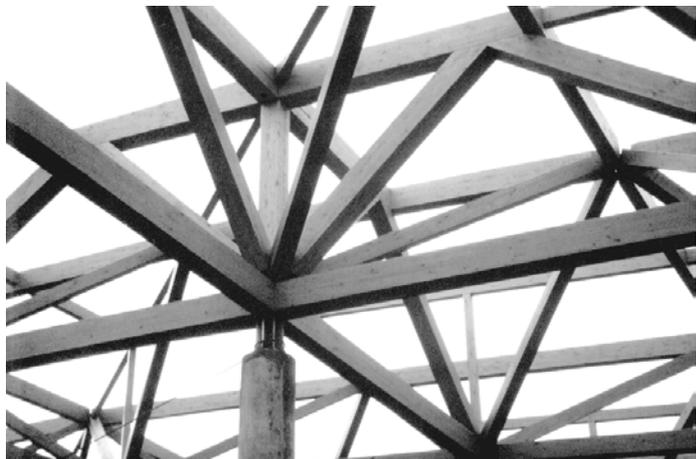
Durch Anordnung einer ebenen, sich überkreuzenden Primärkonstruktion über den Stützen, wurde die Strebenanzahl verdoppelt. Das System ist im linken Bild gesondert dargestellt. Dies ermöglichte die Einleitung dieser für den Holzbau doch relativ hohen Auflagerkraft. Das rechte Bild zeigt, daß sich die zusätzliche Konstruktion dem Grundsystem anpaßt bzw. sich in das Gesamtbild des Tragwerkes einfügt.
