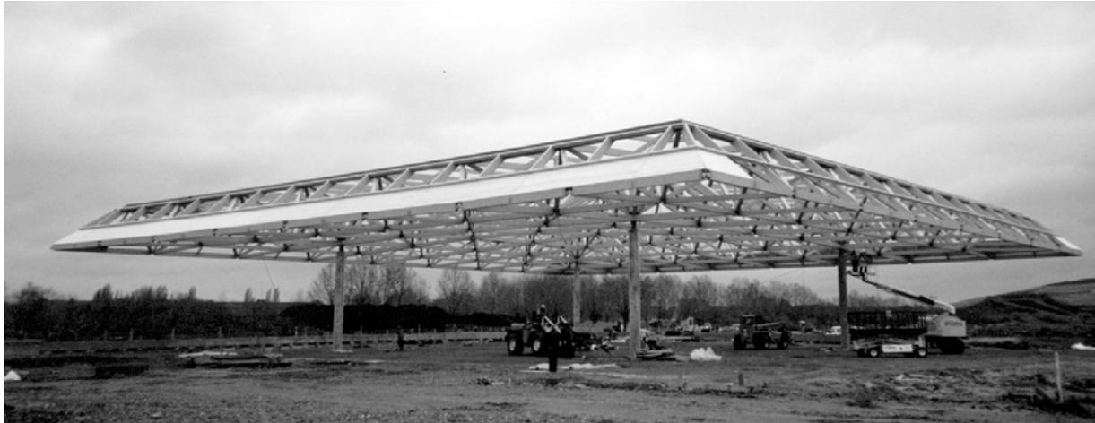
Die Sparren kragen 3 m über die Fassade; sie bilden dadurch, in 6 m Höhe, einen respektablen konstruktiven Wetterschutz. Ober- und Untergurte sind in Zeltdachform um ca.  $3^\circ$  geneigt. Die Konstruktionshöhe beträgt 2,50m.
