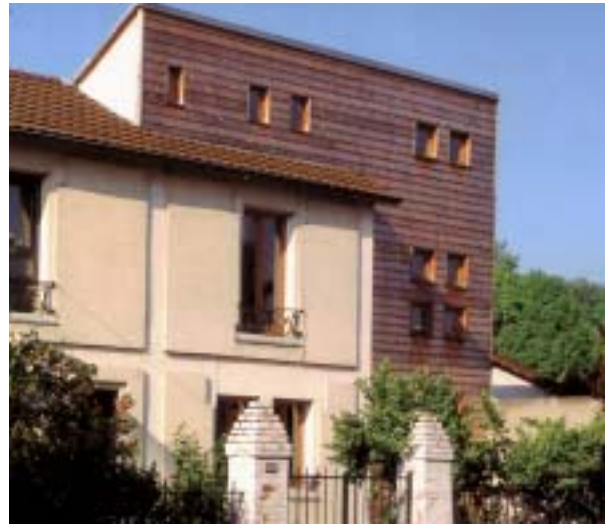
Extension pavillon à Issy architecte :scm « drôles de trames »
