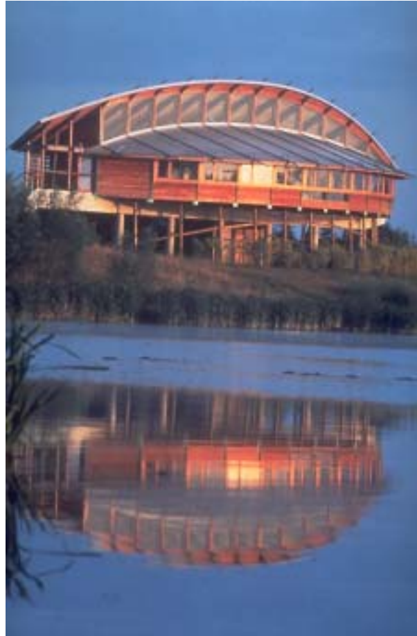
Ecopole du forez architecte Atelier de l'Entre
