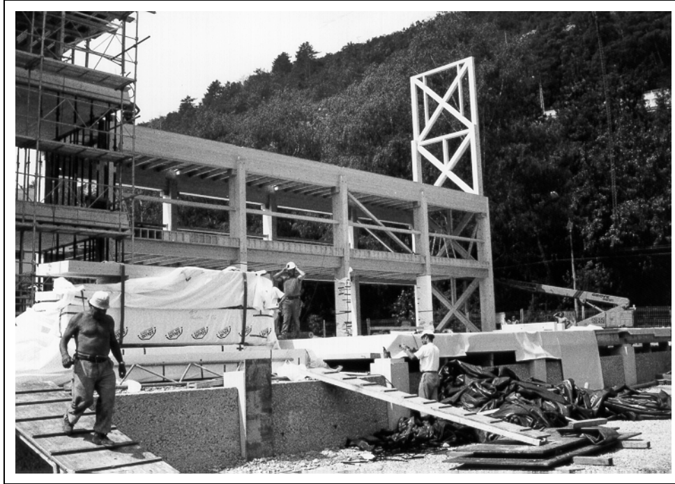
Abb. 10 Fachwerk mit zwei montierten C-Trägern
