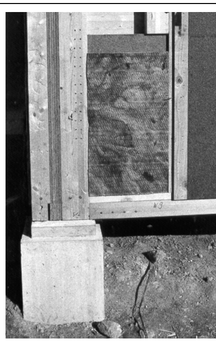
Abb. 5 Montierte Wandelemente
