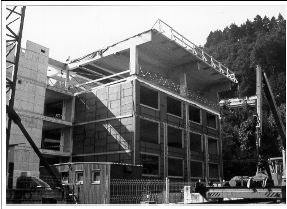
Abb. 15 Fertig montierter Kopfteil vom EG-Boden bis zum Unterdach
