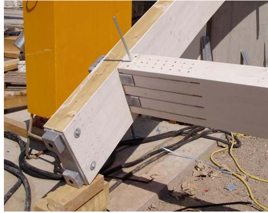
Abbildung 11: Sonderstahlteil Längsträgeranschluss
