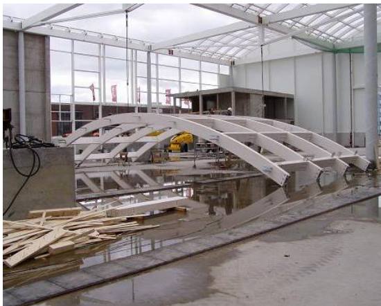
Abbildung 12: 4er-Bund aus Bögen und Längsträgern links im Bild = Beton- Aussteifungswand
