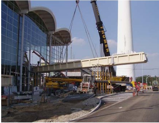
Abbildung 27: Einheben des ersten Hauptträgerteils a 48 to
