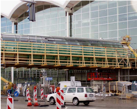
Abbildung 31: Nordseite, eingerüstet, Verglasungen zu ca. 50 % fertig gestellt
