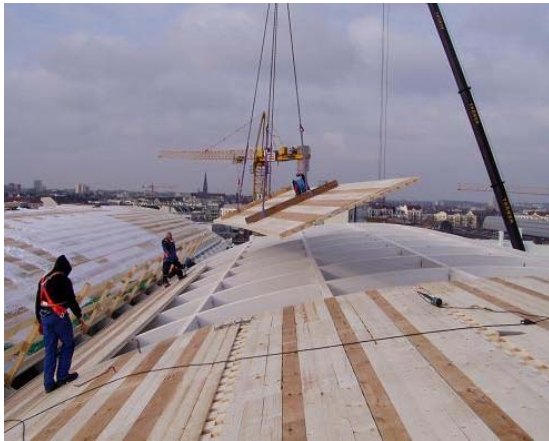
Abbildung 18: Einheben der Lignotrend- Dachelemente
