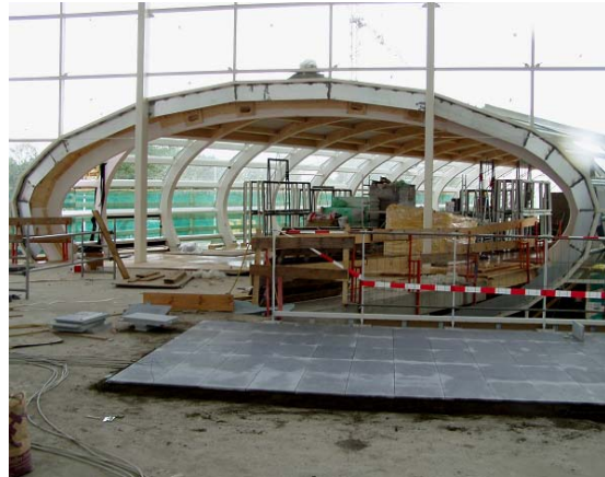
Abbildung 32: Blick in die „Röhre“
