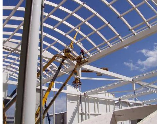
Abbildung 13: Schließen der Konstruktion mit den verbleibenden Längsträgern
