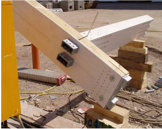
Abbildung 10: Sonderstahlteil Längsträgeranschluss
