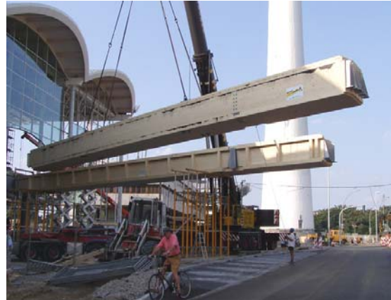
Abbildung 28: Einheben Teil 2 des Hauptträgers
