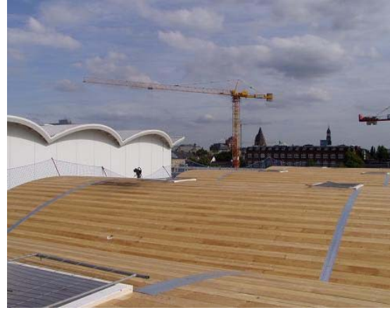
Abbildung 19: Fertig verlegte Lignotrend- Dachelemente
