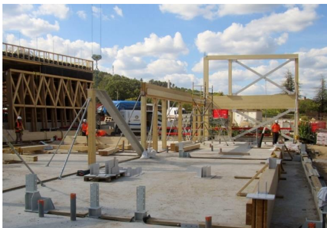
Illustration 6 : Implantation et levage de la structure zone administration
