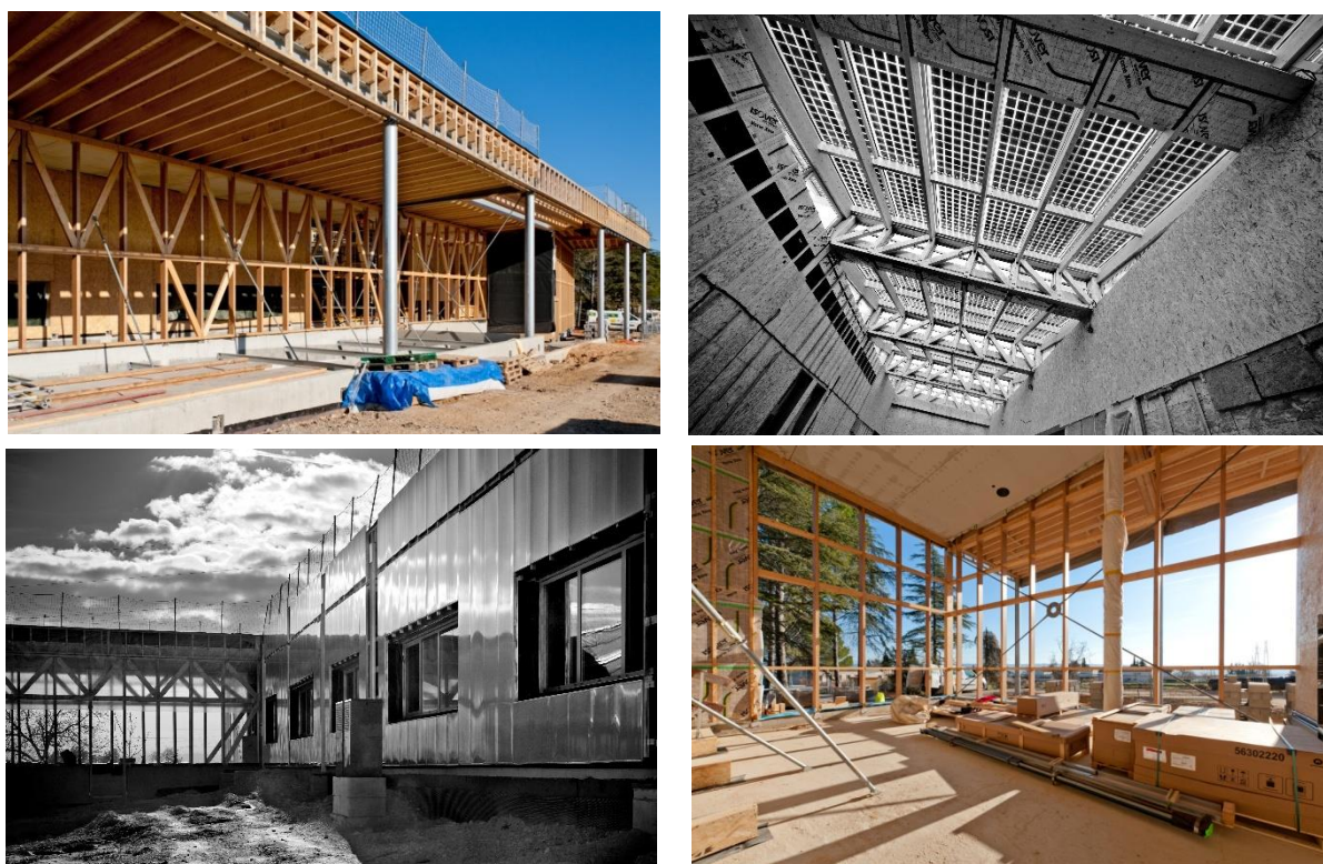
Illustration 2 : Une architecture exemplaire en matière de construction durable
