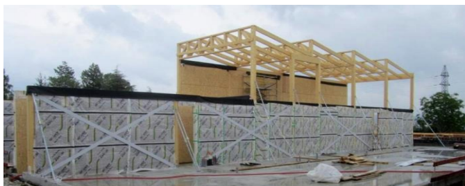
Illustration 7 : Mise en œuvre des murs à ossature bois renforcés
