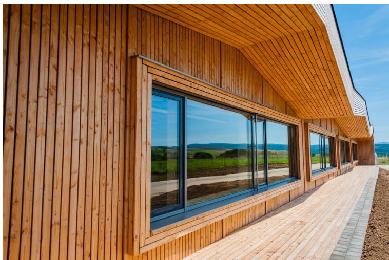
Le groupe scolaire de Hadol (Vosges) est un bâtiment en bois 100% local, issu des forêts communales. Hêtre, sapin, douglas, cet ouvrage est un exemple d'économie circulaire.
