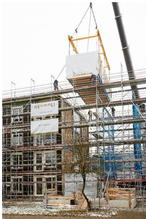
Abbildung 9: Die fertigen Module werden mit dem Tieflader «just in time» geliefert und ins Stahlgerüst eingesetzt.
