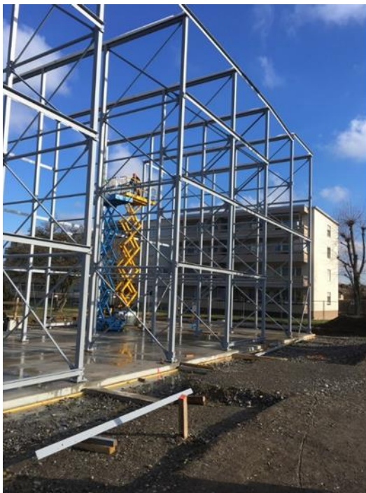
Abbildung 8: Das Stahltragwerk wird in Lenzburg aufgebaut.
