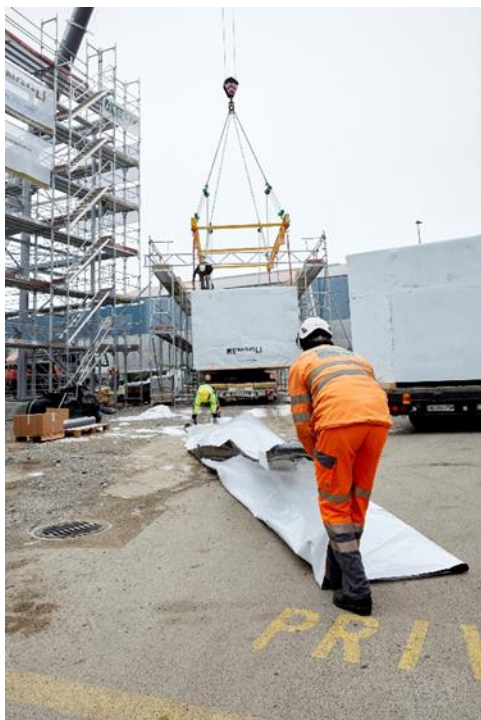
Abbildung 9: Die fertigen Module werden mit dem Tieflader «just in time» geliefert und ins Stahlgerüst eingesetzt.
