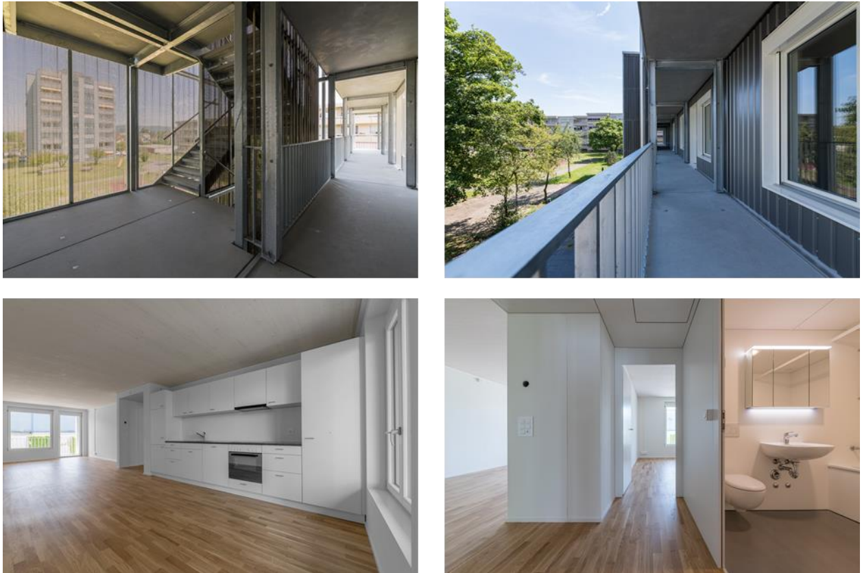
Abbildung 11: Impressionen des fertigen Gebäudes «HELLO Lenzburg» II.
