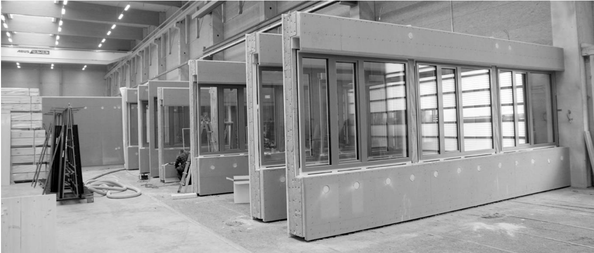
Abbildung 14: Vorfertigung der Elemente
