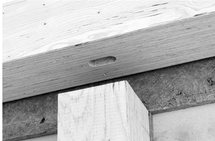
Abbildung 8: Montage Träger auf Stütze
