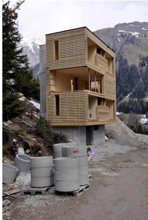
Abbildungen 9-12: Baustelle Chalets, Betonsockel mit Holzbau (Fotos: reitter-strolz)
