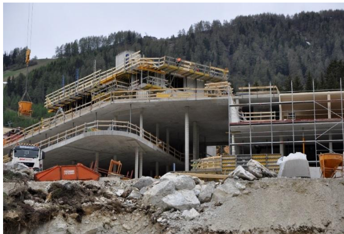
Abbildungen 5-8: Baustelle Hotel; Stahlbetonsockel mit Übergang Holzbau (Fotos: reitter-strolz)
