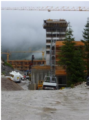
Abbildungen 5-8: Baustelle Hotel; Stahlbetonsockel mit Übergang Holzbau (Fotos: reitter-strolz)
