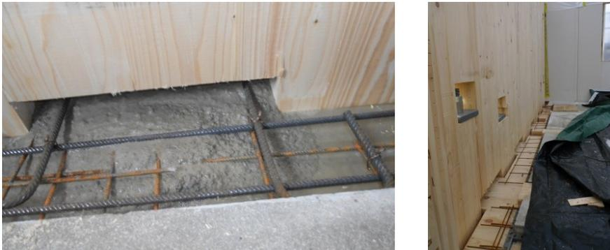
Abbildung 6: Vergiessen der Anschlüsse am Bau (Fotos Implenia)
