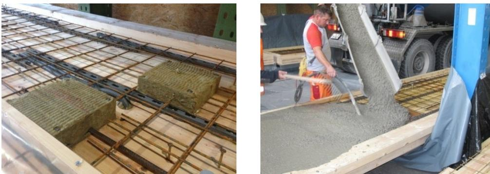
Abbildung 7: Vorfertigung der Holz-Beton-Verbund-Elemente (Foto Balteschwiler Laufenburg)
