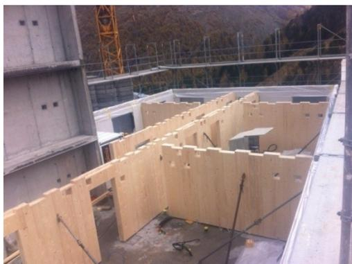
Abbildung 4: Innenwände in Brettsperrholz; Treppenturm in Stahlbeton; Aussenwände in Holzrahmenbauweise
