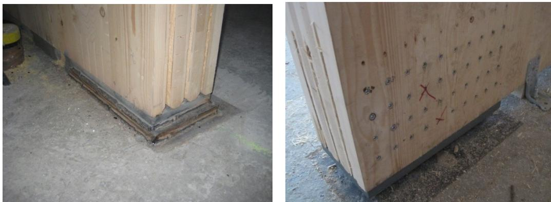
Abbildung 1: Verankerung der Brettsperrholzplatten mittels in den Stahlbeton eingelegten Schweissgrundplatten
