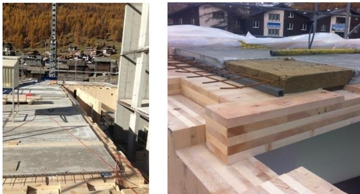
Abbildung 3: Verzahnung der Deckenelemente und der Innenwandelemente in Brettsperrholz mit den „Holzzinnen“
