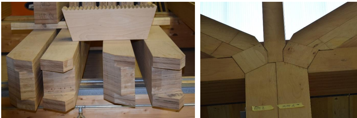
Abbildung 7: Rechts: Abbund der Diagonalen und der zugehörigen Knagge des Mittelauflegerknotens; Links: montierter Knoten.
