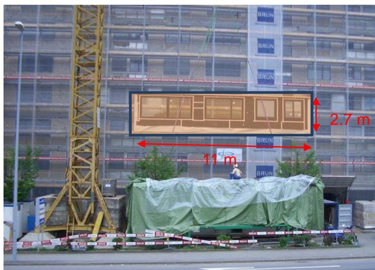
Illustration 4: La préfabrication permet de limiter le temps de montage. Cet avantage est prépondérant particulièrement en situation urbaine et lorsqu'on intervient sur un immeuble occupé, comme c'est le cas dans cet immeuble situé à Ebikon. Architecte : Lustenberger&Condrau
