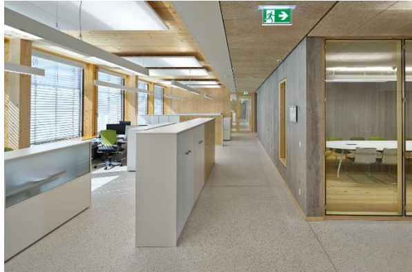
Ablesbares Material- und Konstruktionsprinzip am Beispiel der offenen Büros; Holzelementdecken- und Stützen, Betonkern mit Sichtbrettschalung und geschliffener Zementestrich.
