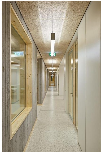
Ablesbares Material- und Konstruktionsprinzip am Beispiel der offenen Büros; Holzelementdecken- und Stützen, Betonkern mit Sichtbrettschalung und geschliffener Zementestrich.
