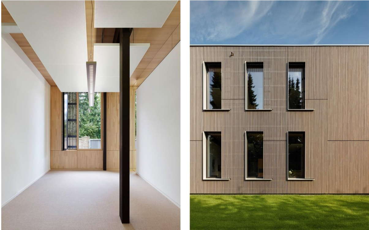
Abbildung 12: Fensterlüftung Büroraum, Fensterdetail Westfassade mit verdeckten Lüftungsflügeln
