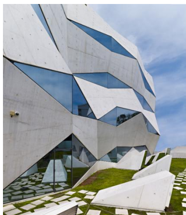
Abbildung 6: Passive Gebäudehülle (Head Office Vodafone, PT-Porto (2010); Barbosa E Guimaraes, LDA, Matosinhos)
