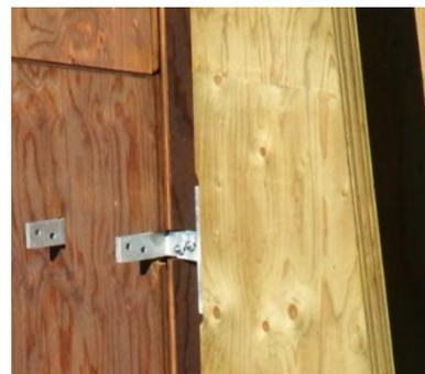
Abbildung 13: Stahlschwerter Fassade
