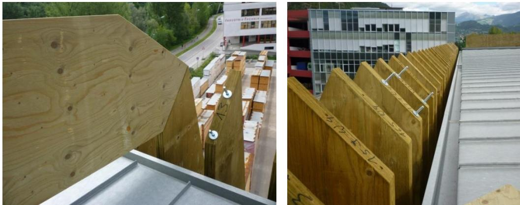
Abbildung 15: Verbindungsstoß Fassaden- + Dachlamelle
