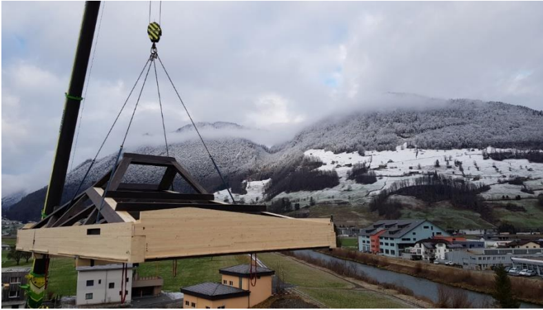
Abbildung 8: zusammengesetzte Dachhaube Fotografie: Pirmin Jung AG, Rain
