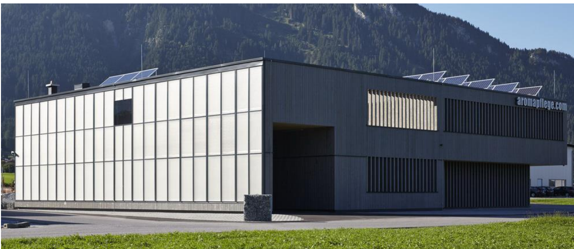
Abbildung 9: Gewerbeobjekt in Österreich. Aromacampus Baujahr 2016. In Lechaschau Österreich Bj. 2016 mit 770 m 2 Nutzfläche, Niedrigstenergiestandard Hz rund 28.000 kWh/a, rund 30 kWh/m 2 a, Solarthermiefassade 140 m 2 mit 25 m 3 Langzeitwärmespeicher, Photovoltaik 24 KWp mit 40 kWh Akku LiIo, Restenergiebedarf wird gedeckt mit Rapsöl BHKW, Solare Deckung Wärme ca. 76 %, Solare Deckung Strom ca. 80 %, Bildquelle: Holzbau Saurer Fotograf Müller
