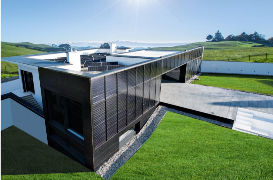
Abbildung 5: VitalSonnenhausPro der Firma Bauhütte Leitl-Werke GmbH: Entwurf des ersten energieautarken Gebäudes Österreichs, derzeit in Schwertberg/Österreich im Bau, Fertigstellung Oktober 2016. Es ist barrierefrei. Wärme, Strom und Mobilität kommen von der Sonne. Zum Einsatz kommen Solarthermie mit Langzeitwärmespeicher, Photovoltaik und Akku sowie Pelletkessel mit Sterlingmotor. Quelle: Bauhütte Leitl-Werke
