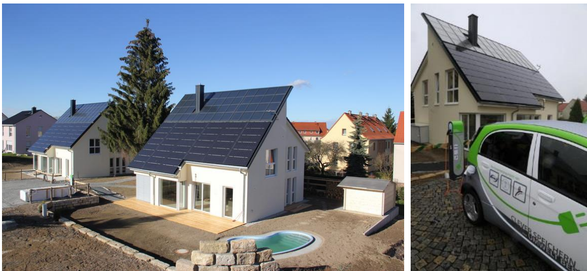
Abbildung 4: Intelligente Eigenversorgung mit Wärme, Strom und Mobilität aus der Sonne. Das Haus wird zur Tankstelle. Es hat eine Wohnfläche von 161 m 2 , Solarthermie 46 m 2 mit 9 m 3 Langzeitwärmespeicher, 8,4 KWP Photovoltaik mit 58 kWh Akku. Die ersten beiden bewohnten energieautarken Einfamilienhäuser Europas in Freiberg/Sachsen, errichtet von der HELMA Eigenheimbau AG Baujahr 2013. Drei Jahre lang werden diese beiden Häuser durch die TU Bergakademie Freiberg messtechnisch untersucht. Primärenergiebedarf: 7 kWh/m 2 a, Stromverbrauch 2.100 kWh/a, Holzbedarf 2-3 rm/a.
