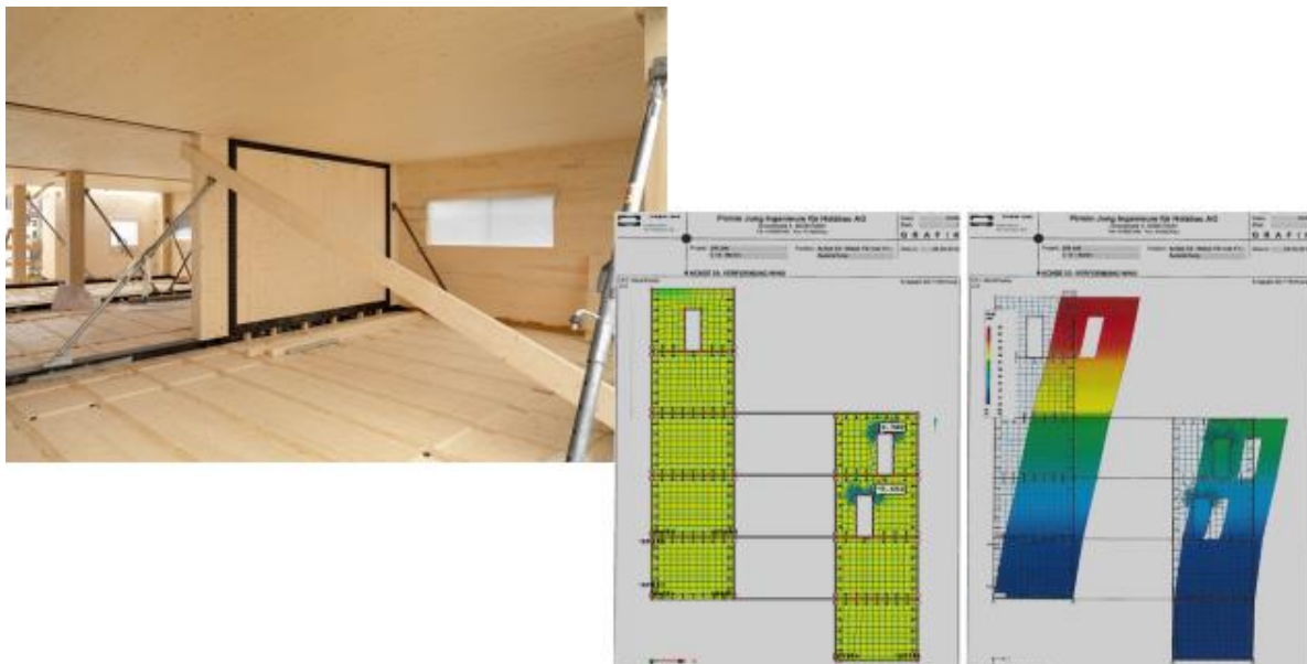
Abbildung 22: Links: Baustellenfoto mit einer in den Hauptstützen und in den Unterzügen eingespannten Brettsperrholzplatte. Rechts: Auszug aus der statischen Bemessung bezüglich der Bemessung dieser aussteifenden Wand, die ein Teil des horizontalen Tragwerkskonzeptes ist.
