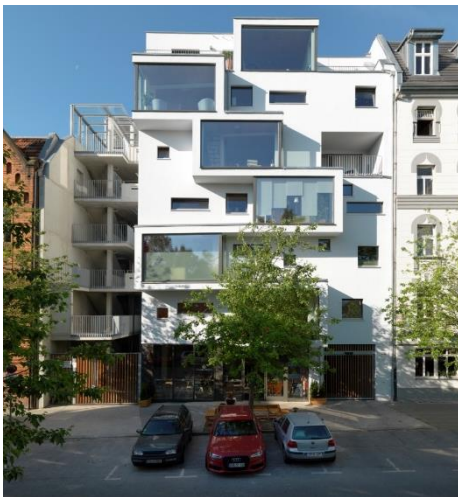
Abbildung 20: C13 in Skelettbauweise mit Unterzug-Stützenkonstruktion und nichttragenden Aussenwänden in Rahmenbauweise (5-geschossigen Teil) und in Brettsperrholzbauweise (7-geschossiger Teil).
