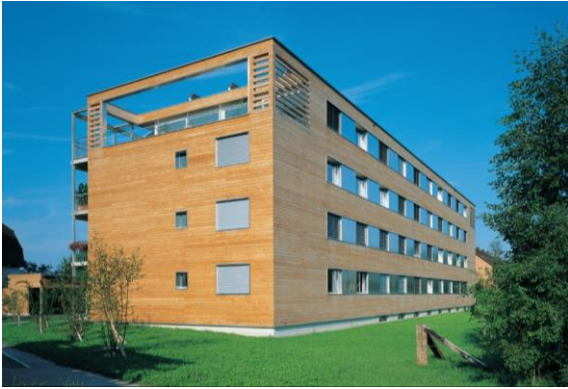
Abbildung 2: Für den 4-geschossigen Genossenschaftsbau AWZ in Zug (Schweiz) wurde 1999 die Skelett/Rahmenbauweise entwickelt, um die Schwachstellen der Rahmenbauweise für den mehrgeschossigen Holzbau zu eliminieren.
