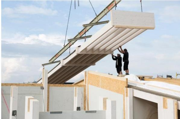
Abbildung 10: Montage der Dachelemente
