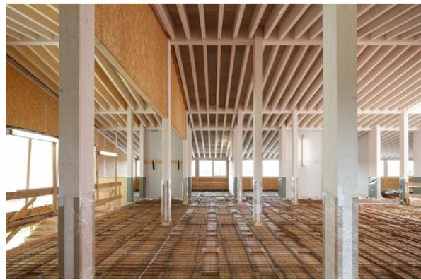
Abbildung 11: HB Verbunddecke mit Schubkernen kurz vor Einbringung des Ortbetons
