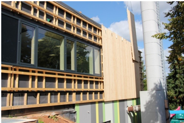
Abbildung 24: Montage Fassadenpaneel, Bild: RC+P
