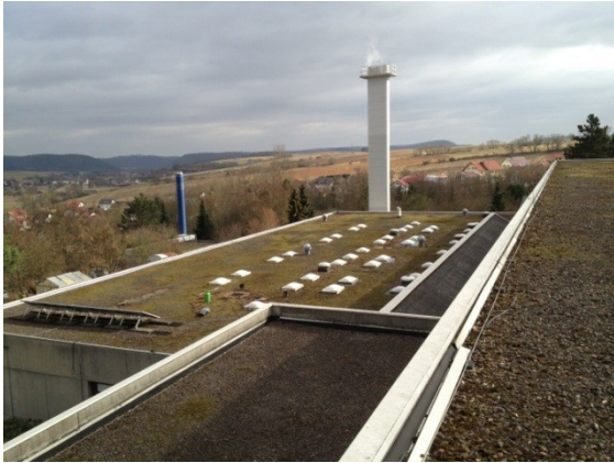
Abbildung 3: Flachdach Ostseite, Bild: C+P
