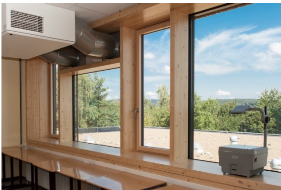
Abbildung: 34: Fassadenanschlüsse innen, Bild: C+P/ SF
