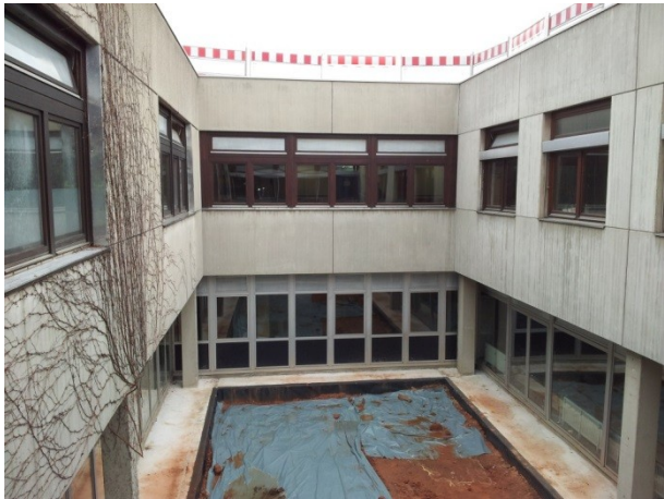
Abbildung 25: Innenhof Betonfassade, Bild: C+P
