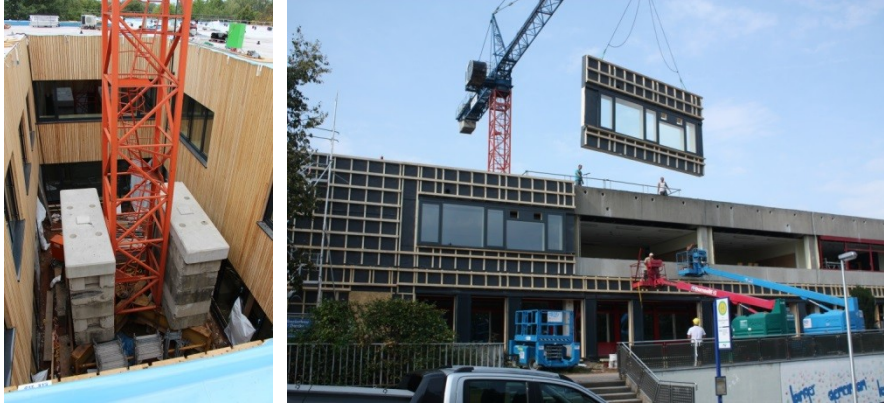
Abbildung 22 und 23: Platzierung Kran, Elementmontage, Bild: C+P
