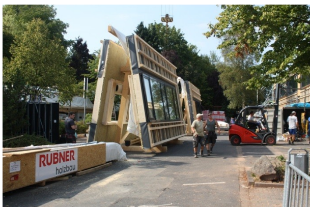
Abbildung 21: Baustellenvormontage, Bild: RH
