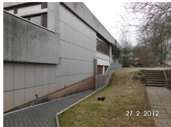
Abbildung 6: Verkleidete Nordfassade, Bild: C+P
