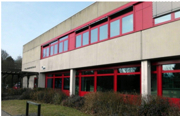
Abbildung 26: Fassadenansicht, Bild: RC+P
