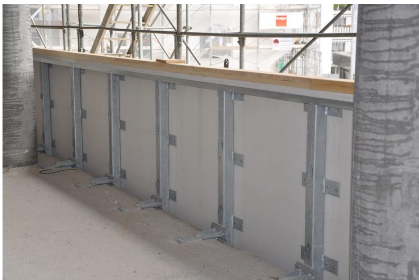
Abbildung 14: Die CD-Clips werden auf die Metallpfosten geschossen
