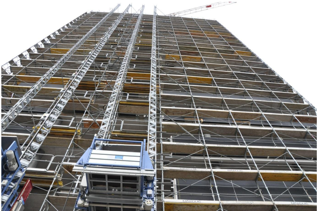
Abbildung 2: Stand der Arbeiten 24.09.2014 – es fehlen noch fünf weitere Geschosse.
