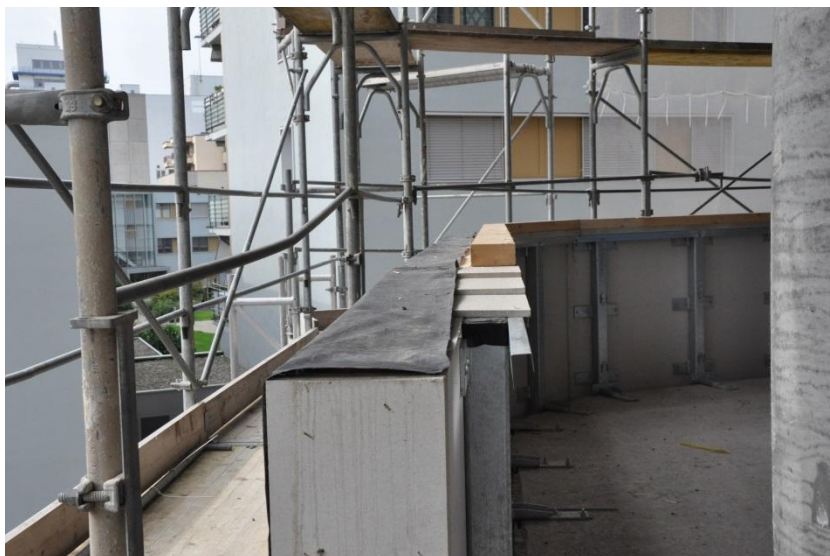
Abbildung 13: Verkleidung Elemente und Unterkonstruktion für Fenster
