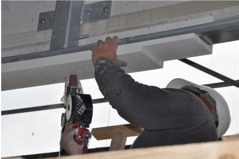
Abbildung 15: Befestigung der ersten zwei Lagen Gipsfaserplatte 18 mm
