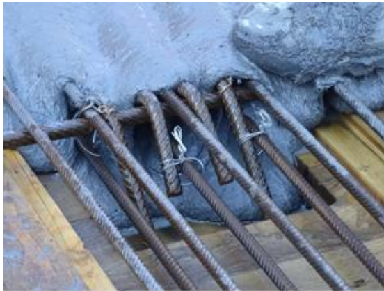
Abbildung 7: Schubverbinder mit Bewehrung
