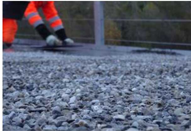
Abbildung 8: Splitt-Einstreuung in UHFB Schlämme
