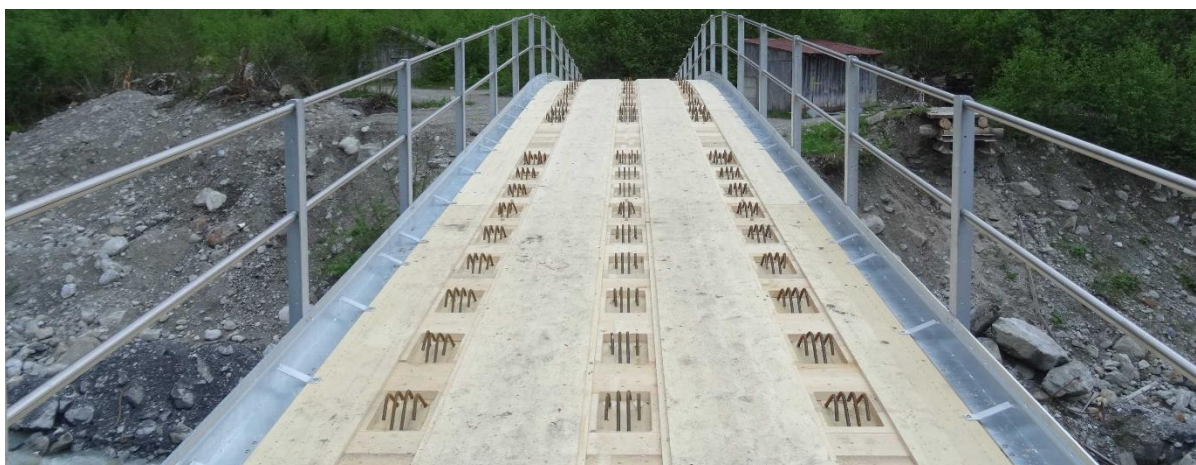
Abbildung 5: Vorgefertigte Schalungselemente und eingeleimte Schubverbinder
