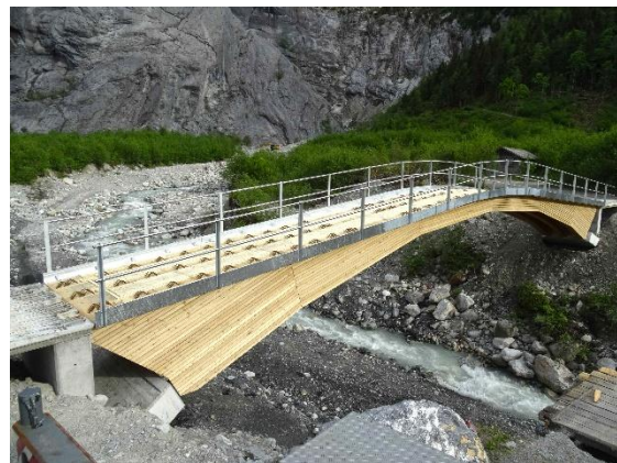
Abbildung 4: Seitliche Holzrostelemente
