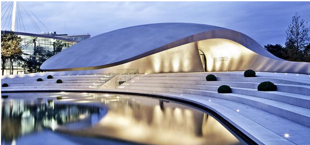
Abbildung 1: Das Gebäude ganzheitlich umschließende Gebäudehülle | Porsche Pavillon Wolfsburg | Henn
