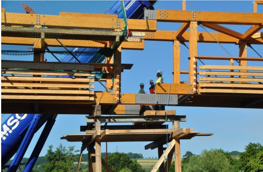
Abbildung 17: Übergangsbereich zwischen Montageabschnitt 2 und 3
