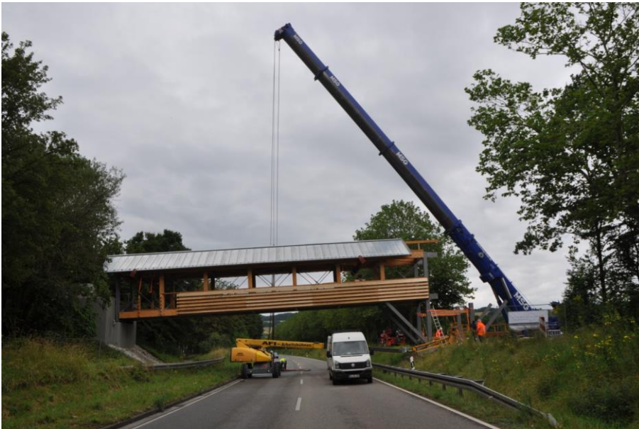
Abbildung 12: bereits eingehobener Montageabschnitt 1 über der B317
