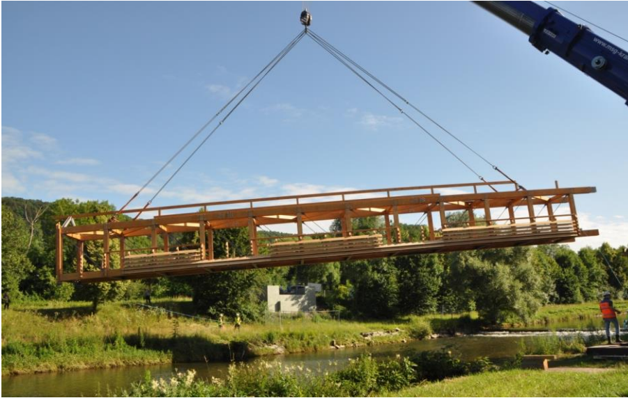
Abbildung 16: Montageabschnitt 3 beim Einheben
