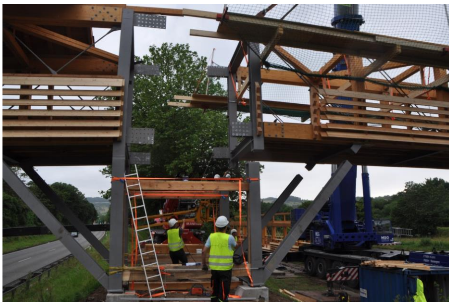
Abbildung 14: Blick gegen Achse 80 und 90 als Koppelstelle zwischen Montageabschnitt 1 und 2 Dann werden die fehlenden «Gurtstücke» zwischen den Achsen 80 und 90 eingebaut.
