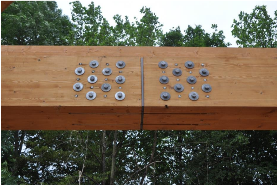
Abbildung 10: am Bauwerk umgesetzter Gurtstoß
