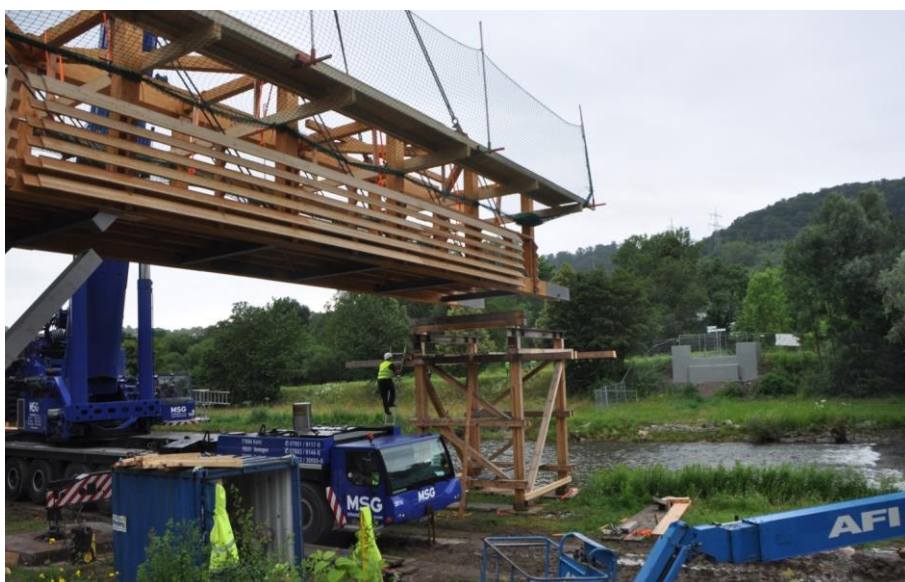
Abbildung 15: Blick gegen das Montagegerüst zwischen Achse 140 und 150 mit Pressenauflegemöglichkeit Am Montagegerüst zwischen den Achsen 140 und 150 besteht die Möglichkeit, die Höhenlage des Überbaus über Pressen fein zu justieren. Das ist erforderlich, um beim Einheben des Montageabschnitts 3 die endgültige Gradienten zu erreichen und so die gewünschte Überhöhung in der Ansicht zu ermöglichen.
