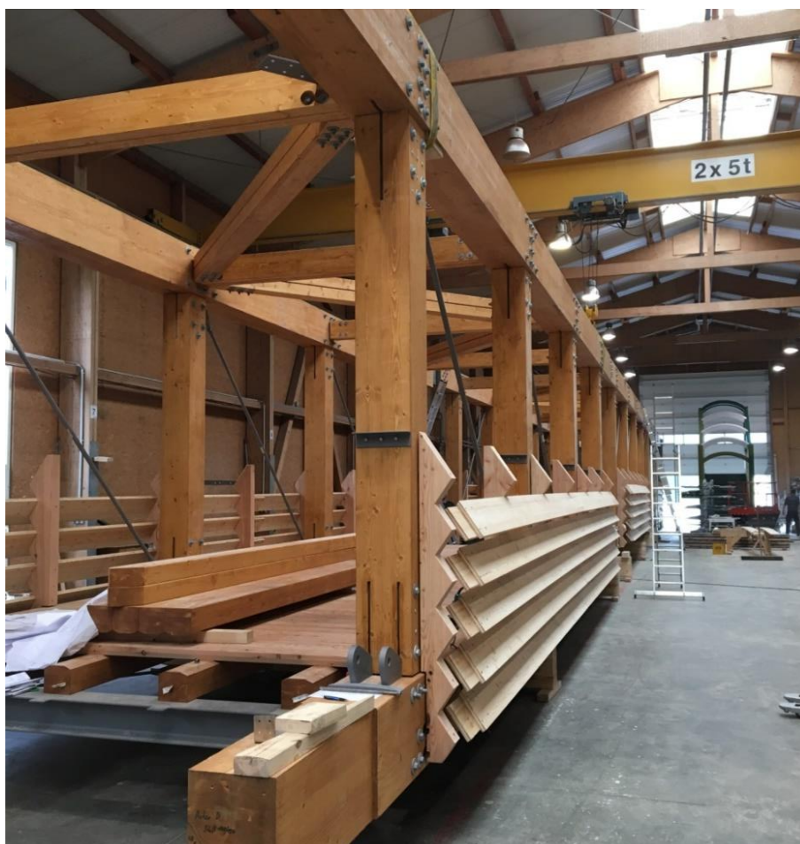
Abbildung 8: Brückensegment während der Fertigung
