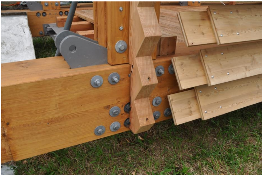
Abbildung 7: Konstruktiver Holzschutz der unteren Fachwerkknoten
