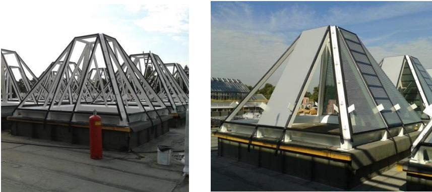
Abbildung 7: Konstruktionsstufen der Dachpyramiden.
