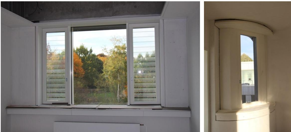
Abbildung 12: Laibungen, Simse und Abdeckungen/Klappen für Brüstungskanäle ergänzen den Fassadenbau.
