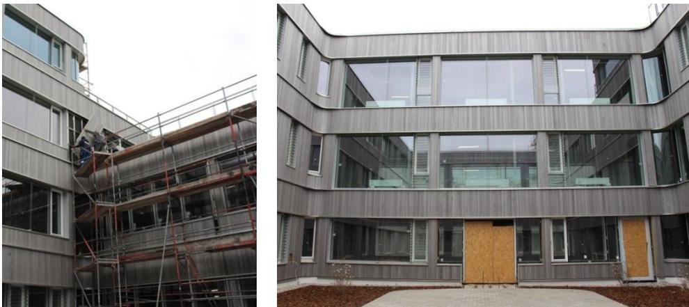
Abbildung 17: Montage von Einhänge-Paneelen – Blick in einen der Binnenhöfe.
