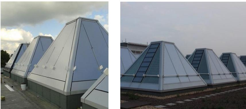
Abbildung 8: Komplettierte Dachpyramiden mit Lamellenfenstern zur Nachtlüftung.
