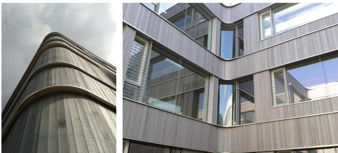
Abbildung 14: Die Ausbildung konvexer und konkaver „runder“ Gebäudeecken bedingte auch im Bereich der Wandelemente eine Produktion nach Aufmaß und bauseitige Detaillösungen.
