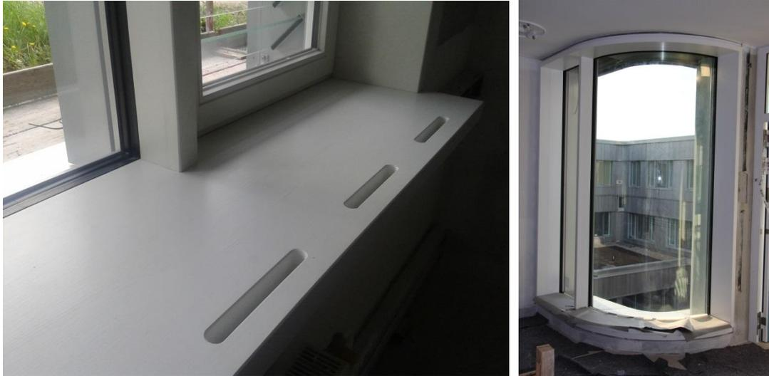
Abbildung 11: Der Schutz der Fassadenelemente in Ausbauqualität stellt eine Herausforderung im Baustellenbetrieb dar.
