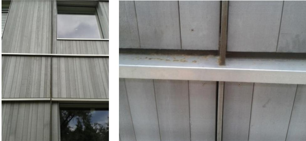
Abbildung 15: Sicherung gegen Brandüberschlag vertikal durch Fermacellplatten und horizontal durch Bleche.
