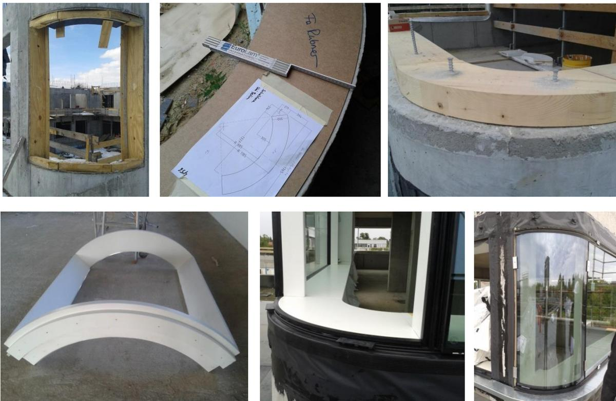
Abbildung 10: Runde Ecke: Rohbauschalung – Schablonenbau – Fertiges Element mit Abdichtung und Verglasung.
