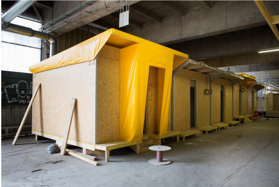
Illustration 8 : Étanchéification extérieure en bâche
