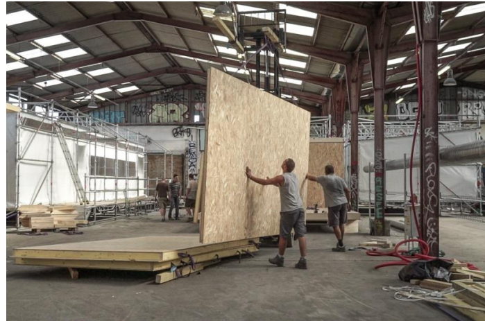
Illustration 6: Montage des chambres
