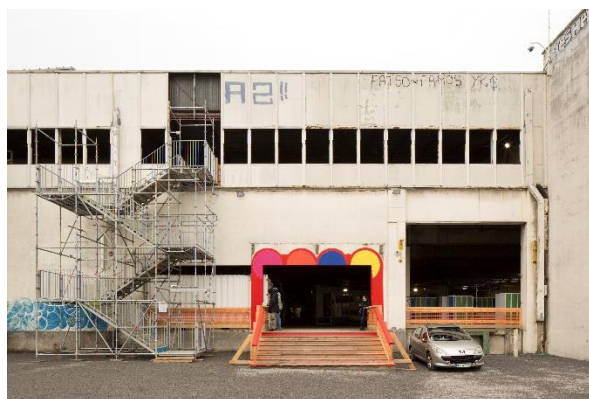
Illustration 3 : Interventions sur la façade
