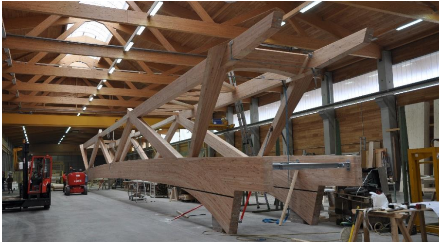
Abbildung 11: Zusammenbau der Brücke in der Werkshalle
