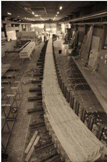
Abbildung 9: Werkstatt mit über 30m langen Trägern
