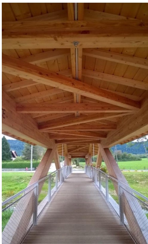
Abbildung 14: Fertiges Bauwerk, im oberen Balken ist zentral eine LED Beleuchtung eingebracht
