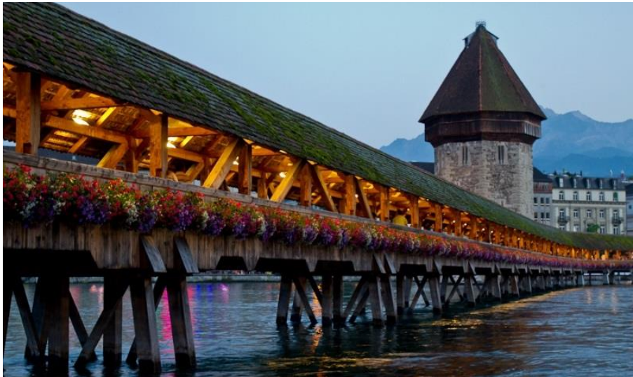
Abbildung 2: Kappelbrücke in Luzern (CH) Holzbau
