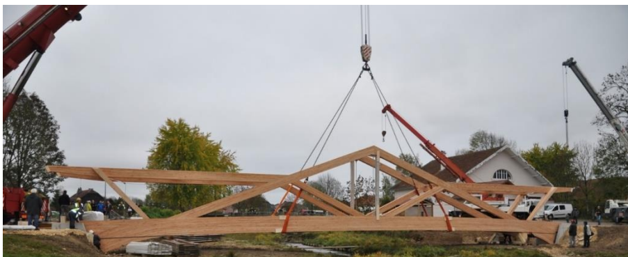
Abbildung 13: Nach einem halben Tag Kranarbeit war die Brücke sicher mit dem Fundament verbunden.
